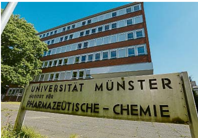
Hier soll der Musikcampus entstehen.
